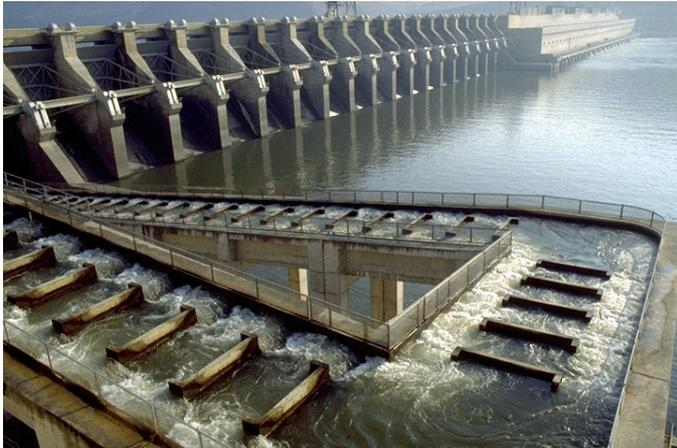
**Echelle à poisson pour le franchissement d'un barrage (source : U.S. Army Corps of Engineers)**
